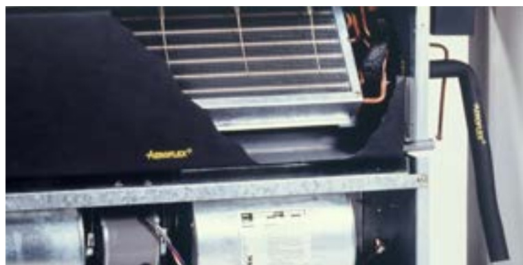
Устойчивость к ультрафиолету и погодным влияниям позволяет использовать Aeroflex EPDM и EPDM HT на улице без покрытий.
