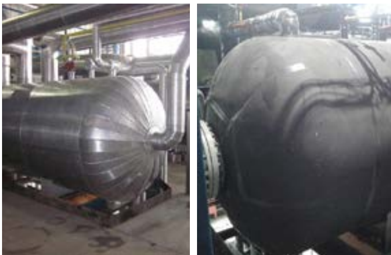
Монтаж материалов Aeroflex не требует сложных крепежных изделий или конструкций.
