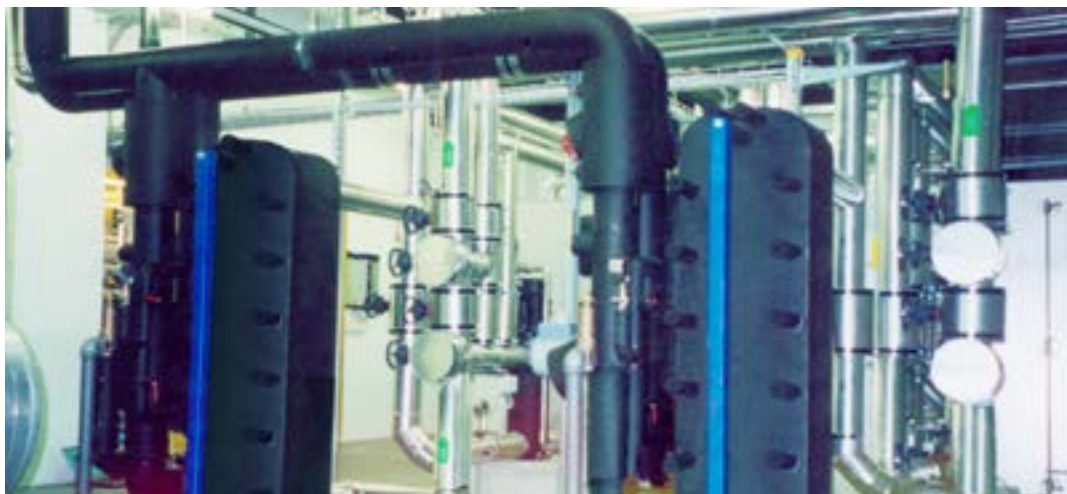
Применение Аерофлекса в качестве тепловой изоляции оборудования тепловых сетей обусловлено низким стабильным коэффициентом теплопроводности и низкой способностью к поглощению влаги.
