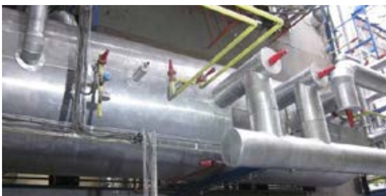
Поверх материалов Aeroflex возможна установка любых видов покрытий, в том числе металлических.
