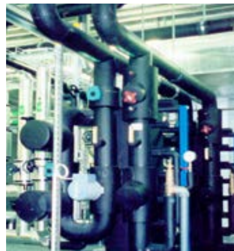
Применение Аерофлекса в качестве тепловой изоляции оборудования тепловых сетей обусловлено низким стабильным коэффициентом теплопроводности и низкой способностью к поглощению влаги.
